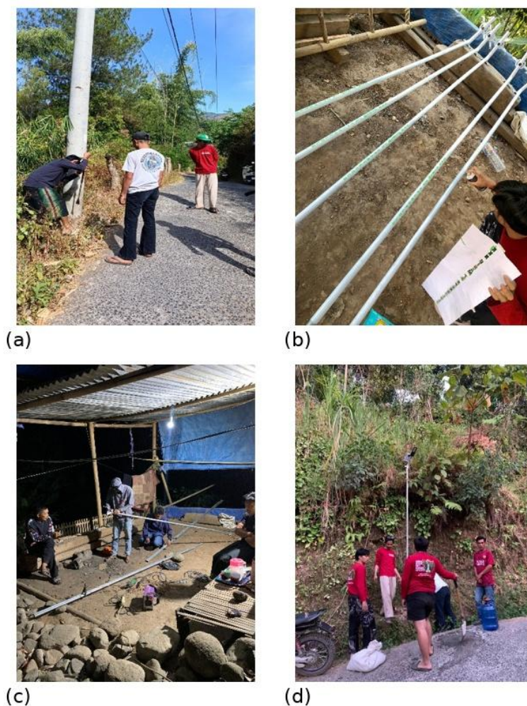
Gambar 2. Dokumentasi proses pemasangan PJU-TS: (a) penggalian lubang tiang; (b) pengecatan tiang; (c) pemasangan unit lampu; dan (d) pemasangan pada titik yang ditentukan.
