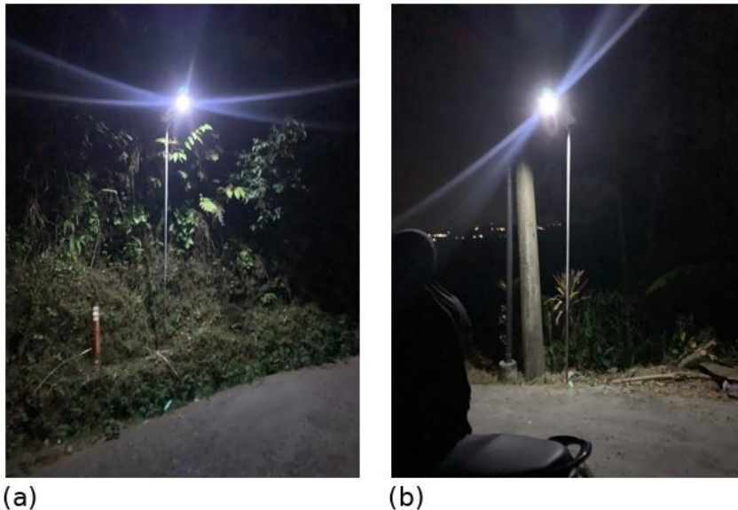
Gambar 4. Kondisi penerangan PJU-TS pada malam hari di titik sasaran.
