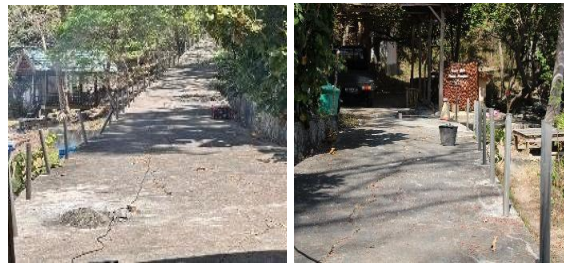
Gambar 3. Kondisi jalan masuk dan pemasangan tiang pengaman
